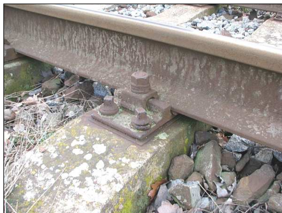
Detail železničního svršku (K) –vedlejší koleje
