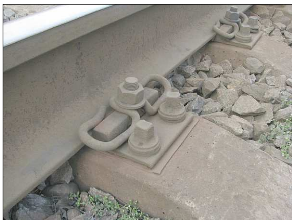
Detail železničního svršku (KS) – průjezdni koleje
